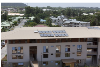
Crédits photo : R. LIETARD - Installation de chauffe eau solaire collectifs
