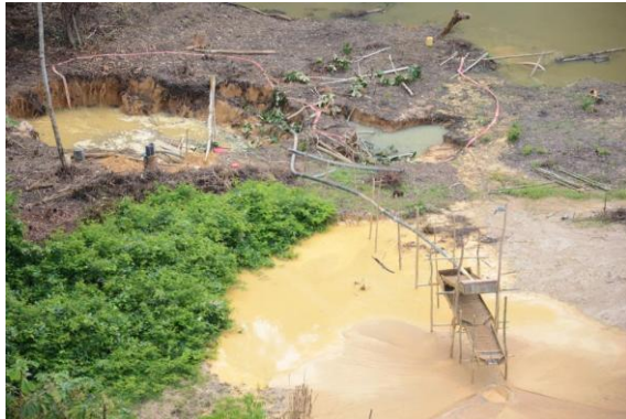
Lipo Lipo : chantier (17/03/2017)
